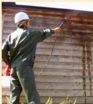
処理例: スプレー処理による塗布
