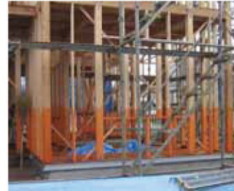
写真1 新築住宅防蟻処理
